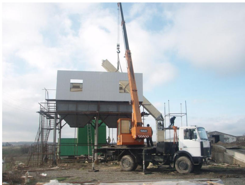
Монтаж наружной нории
